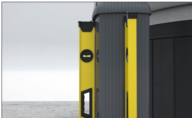
FIGURE 48: VÉRIFIER SI LES COLONNES SONT TOUJOURS DE NIVEAU
