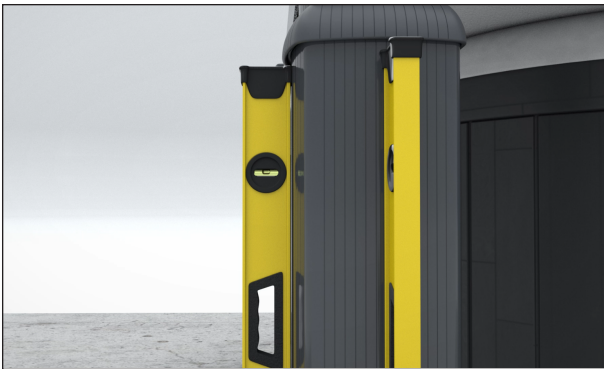
FIGURE 47: VÉRIFIER SI LES COLONNES SONT TOUJOURS DE NIVEAU
